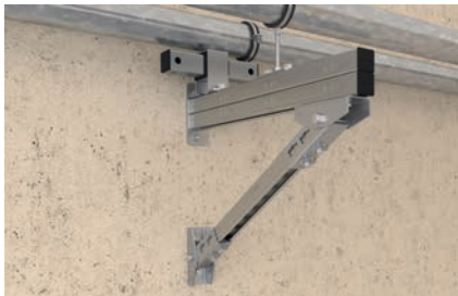
Massive Abstützung von Konsolen
