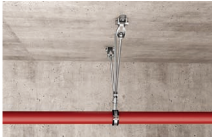
Aussteifung einer Rohrleitung mit Gewindestangen
