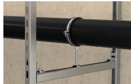
Rohrbefestigung auf Rahmenkonstruktion
