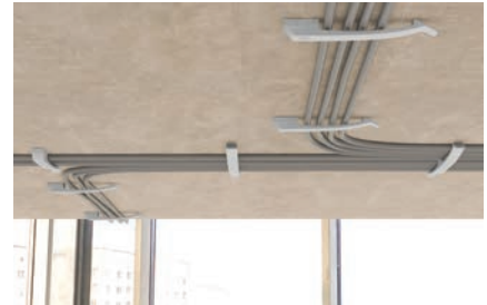
Befestigung von Kabelsträngen
