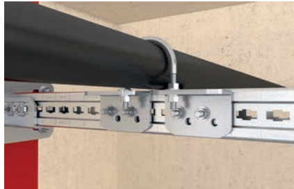
Profiltraverse an Stahlbau
