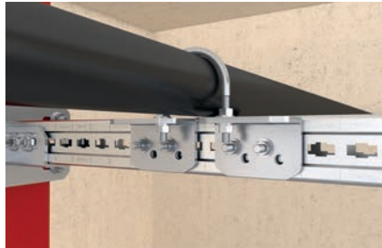
Profiltraverse an Stahlbau
