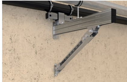
Massive Abstützung von Konsolen
