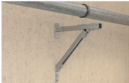
Stahlrohr stehend auf Schwerlastkonsole
