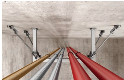
Aussteifung einer Rahmenkonstruktion mit Gewindestangen
