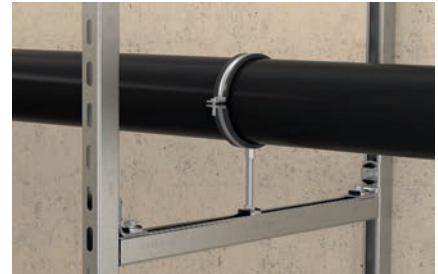
Rohrbefestigung auf Rahmenkonstruktion
