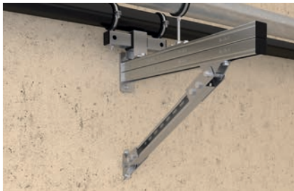
Massive Abstützung von Konsolen
