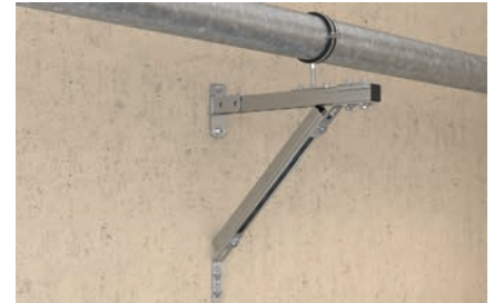
Stahlrohr stehend auf Schwerlastkonsole
