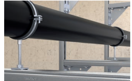
Rohrbefestigung auf Schiene
