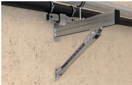
Massive Abstützung von Konsolen
