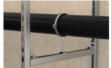
Rohrbefestigung auf Rahmenkonstruktion
