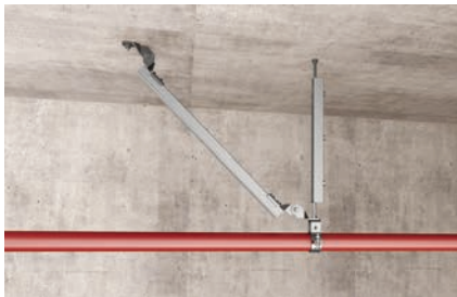
Aussteifung einer Rohrleitung mit Montageprofilen
